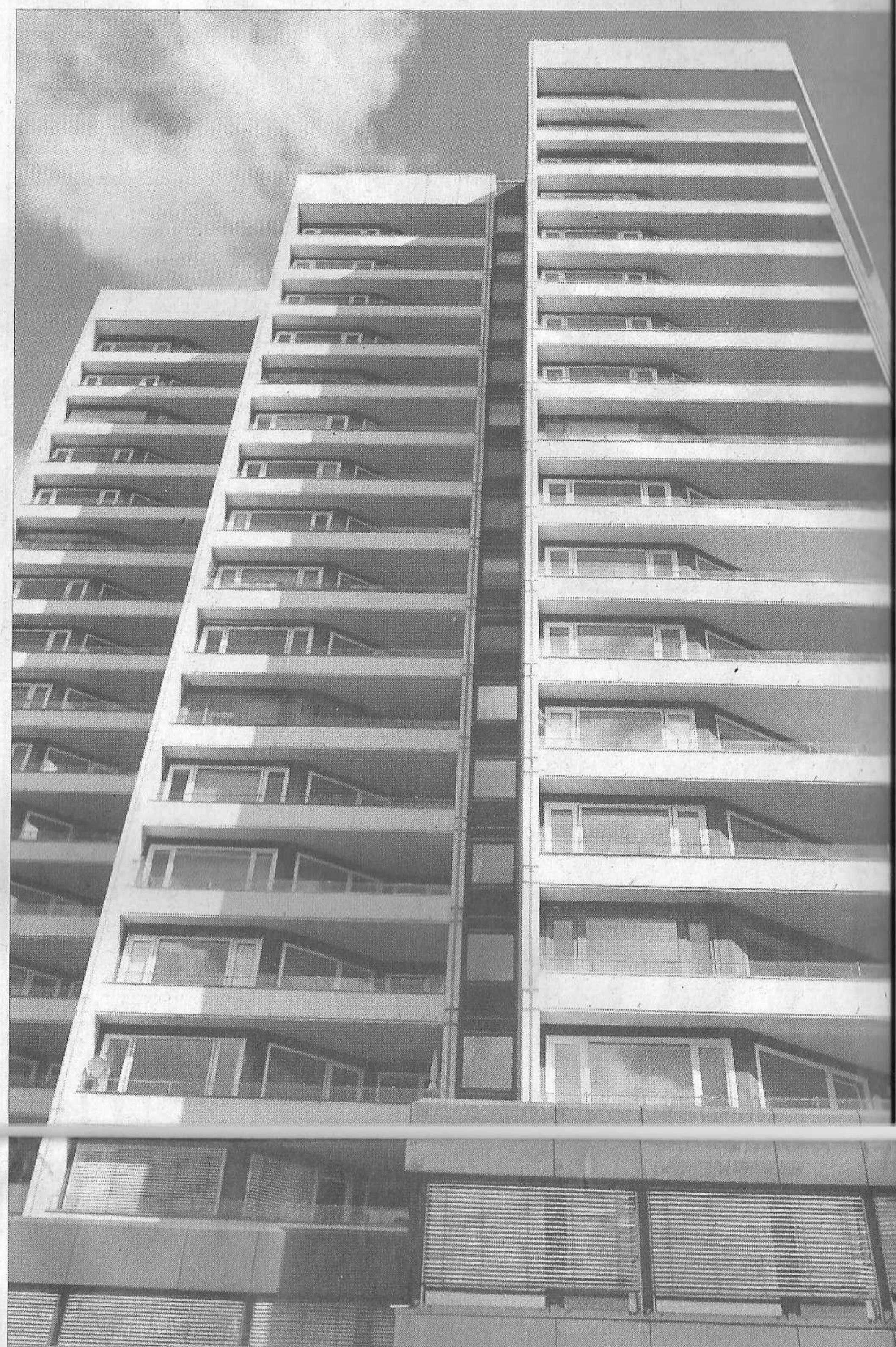
Postmodern wirkt die Fassade heute – 51 Jahre nach der Grundsteinlegung. (Fotos: Hanano)
